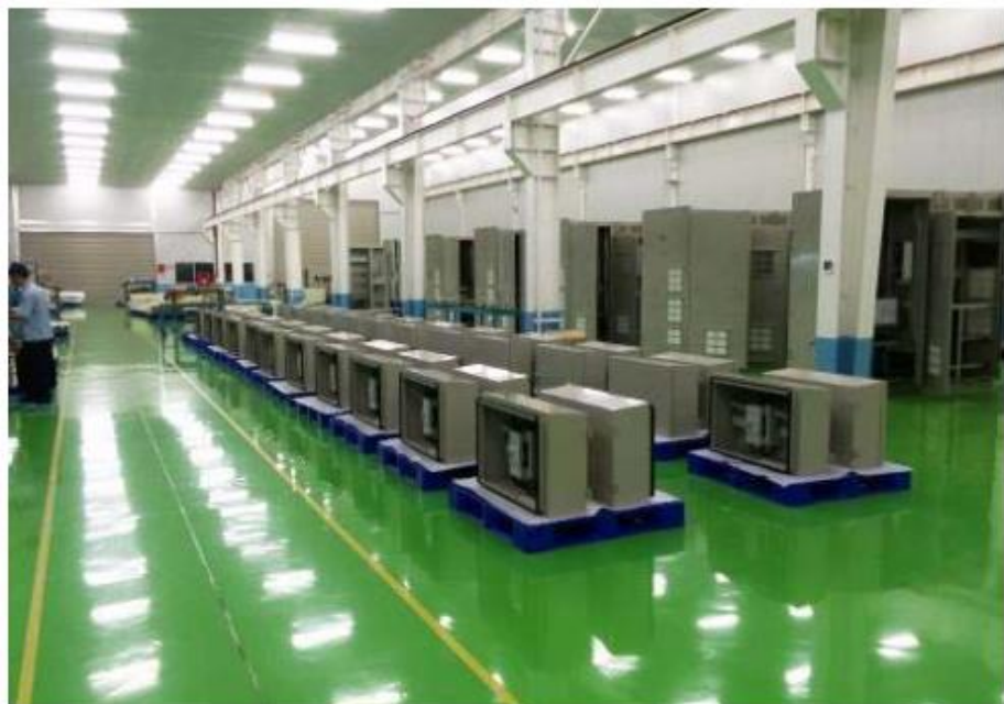
Nhà máy số 1 Phòng lắp ráp tầng 1 (1200m 2 )
